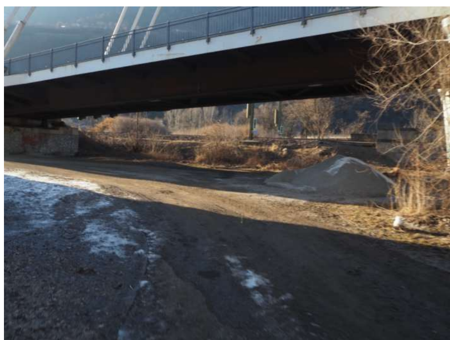
Ponte sull'Isarco della S.P. 28 e linea ferroviaria Brennero – Verona.
