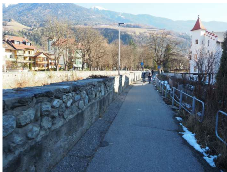
Tratto di ciclovía tra ponte Aquila e via Seminario.
